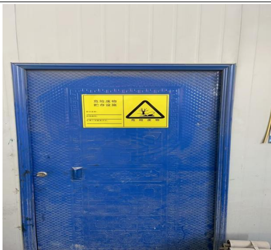
危废间警示牌
